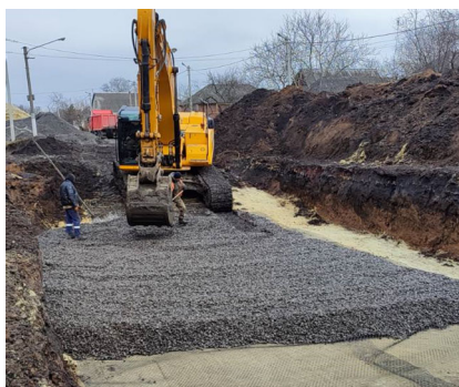
Рисунок 6 – засипання георешітки кам'яним інертним матеріалом Figure 6 – filling the geogrid with stone inert material
