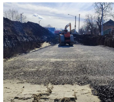
Рисунок 7 – укочування шару механізацією Figure 7 – rolling the layer by mechanization
