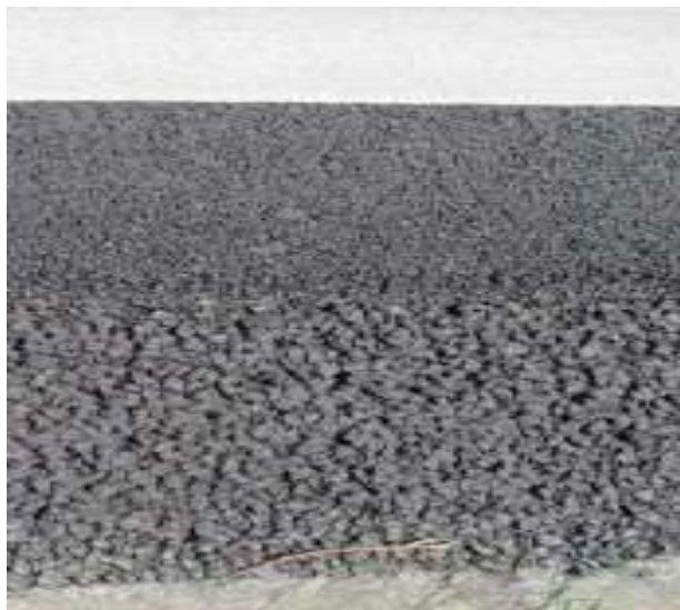
Рисунок 3 – Двошаровий пористий асфальт Figure 3 – Two-layer porous asphalt
