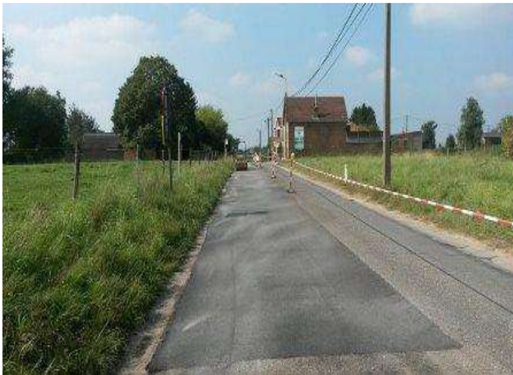
Рисунок 5 – Тестовий трек у Герцелі, Бельгія, побудований у вересні 2014 року (довжина 40 м) Figure 5 – Test track in Herzels, Belgium, built in September 2014 (length 40 m)
