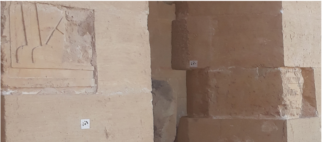
Рисунок 4 – Маркери-наклейки для фотознімання архітектурної/археологічної пам'ятки Figure 4 – Marker stickers for photographing architectural/archaeological monuments
