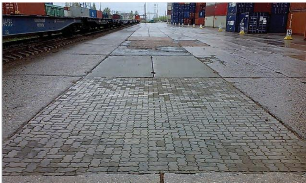
Рисунок 4 – Приклад ремонту із застосуванням каменю «Хвиля»
