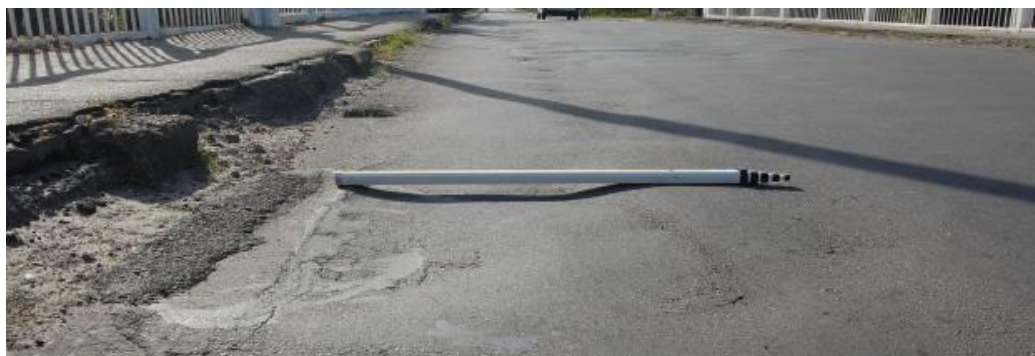
Рисунок 4 – Колійність на проїзній частині мосту (м. Чугуїв)
