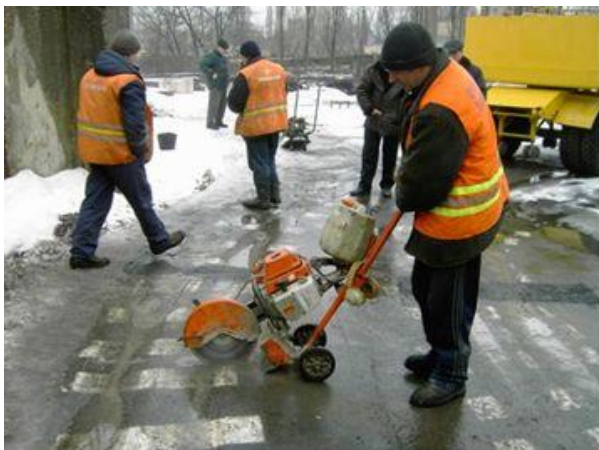
Рисунок 2 - Нарізка виїмки у покритті стенду за допомогою фрези
