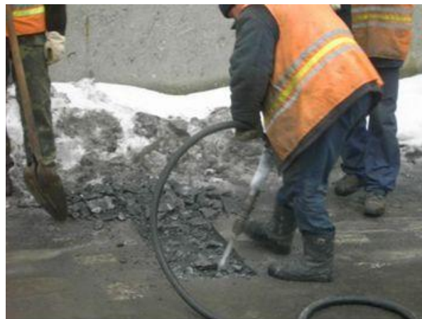
Рисунок 3 - Розробка виїмки за допомогою компресору
