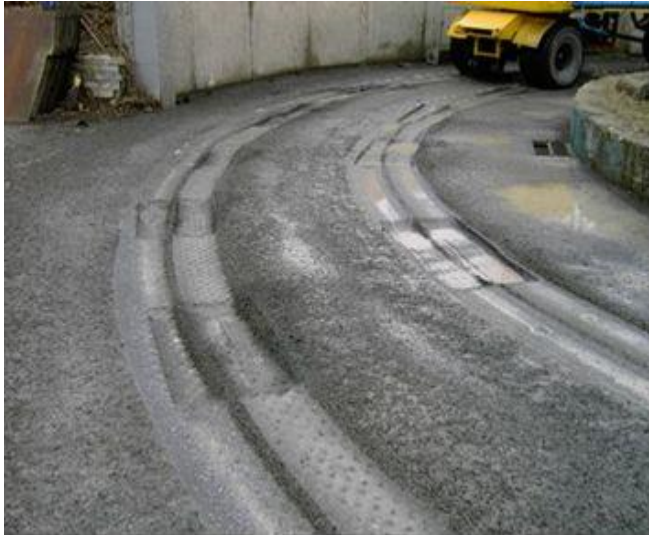
Рисунок 10 - Загальний вигляд ділянки покриття з картами, що втратили закладені матеріали аварійного ремонту
