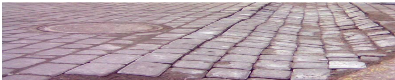
Рисунок 7 – Просідання брукованих покриттів
