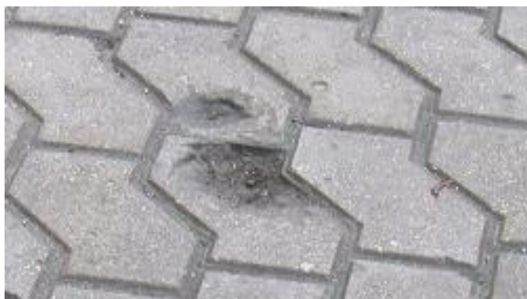
Рисунок 5 – Відколювання частин бетону з утворенням раковин
