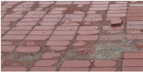
Рисунок 3 – Руйнування, що спровоковане незадовільною морозостійкістю бетонних елементів брукування (розкришування)
