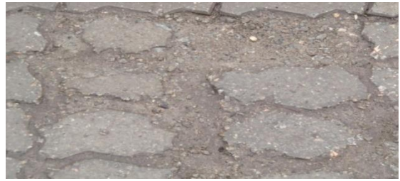
Рисунок 3 – Руйнування, що спровоковане незадовільною морозостійкістю бетонних елементів брукування (розкришування)
