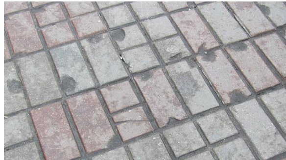
Рисунок 5 – Відколювання частин бетону з утворенням раковин
