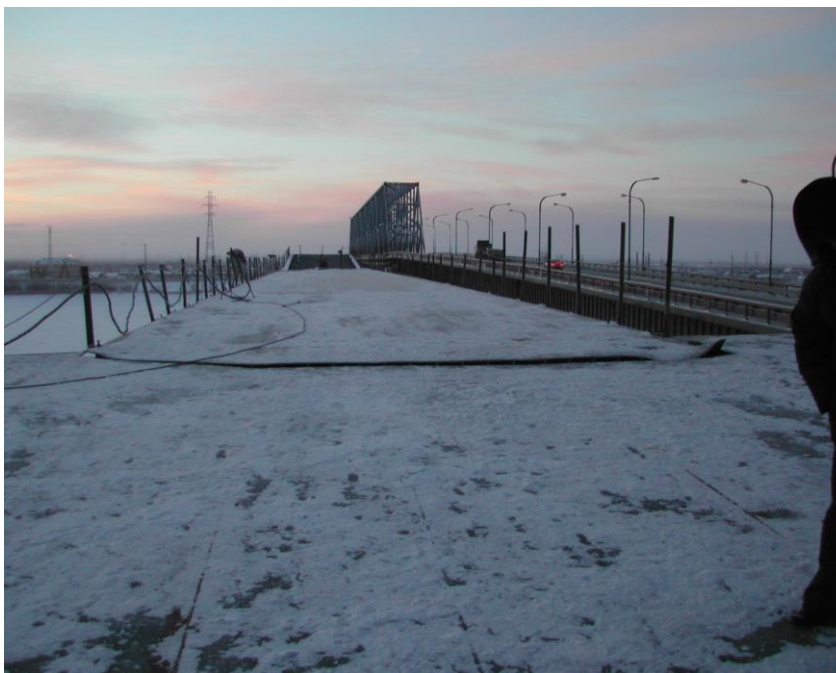
Рисунок 1 – Разрушение пролетного строения моста через Юганскую Обь при надвижке
