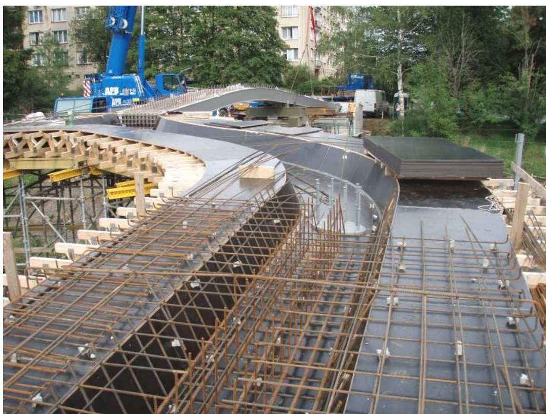
Рисунок 4 – Мост в период строительства
