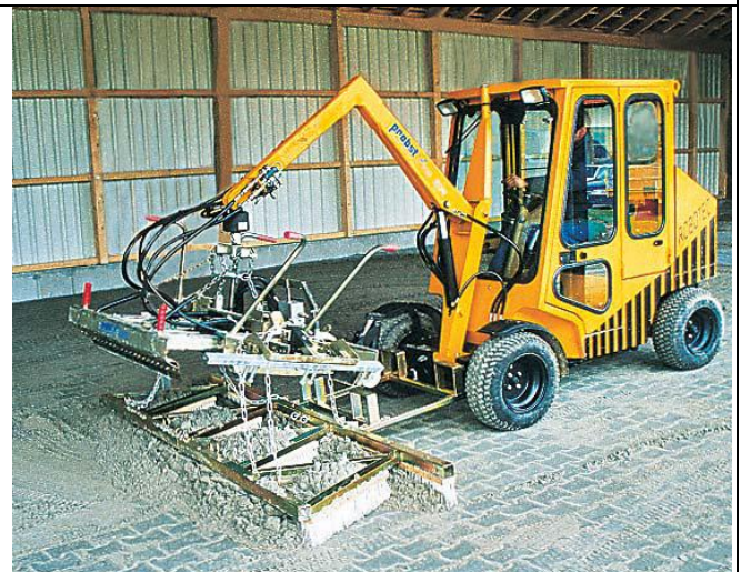
Заповнення швів навісними щітками
