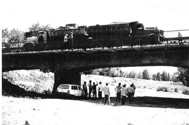
Рисунок 1 - Випробування мосту через р. Ворскла біля с. Білики Кобеляцького району після реконструкції
