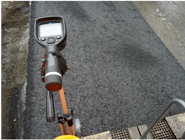
Рисунок 2 – Розташування тепловізора на платформі асфальтоукладача під час зйомки (зліва) та інфрачервоне зображення, що отримане в цьому положенні тепловізора (справа)
