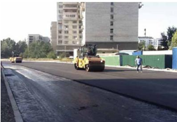
Рисунок 2 – Влаштування асфальтобетонного покриття на ПБВ «Полігум»
