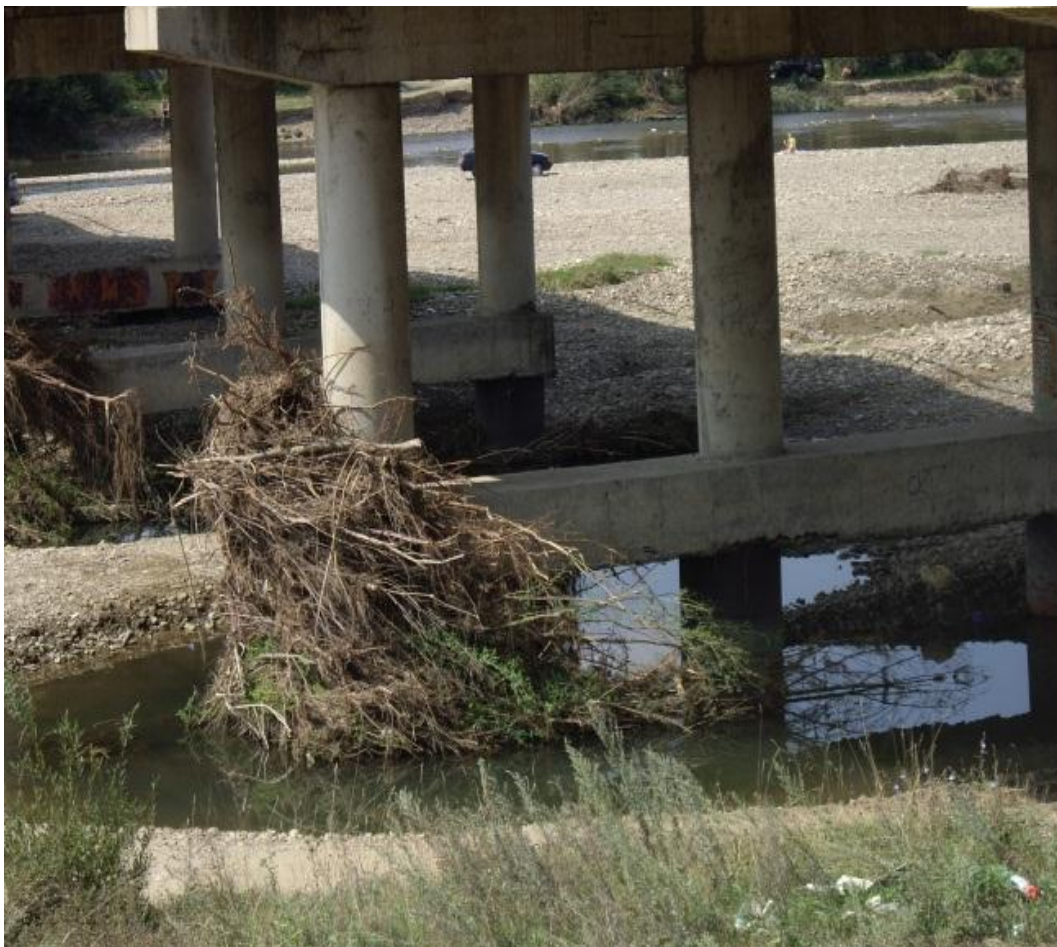
Рисунок 3 – Мостовий перехід через р. Бистриця-Надвірнянська, с.Черніїв, Івано-Франківська обл.
