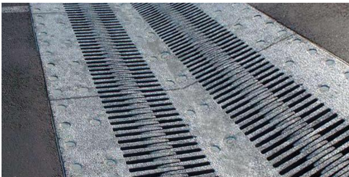
Рисунок 4 - Фрагмент ДШ в плане с гребенчатой плитой с консольными двусторонне направленными пальцами
