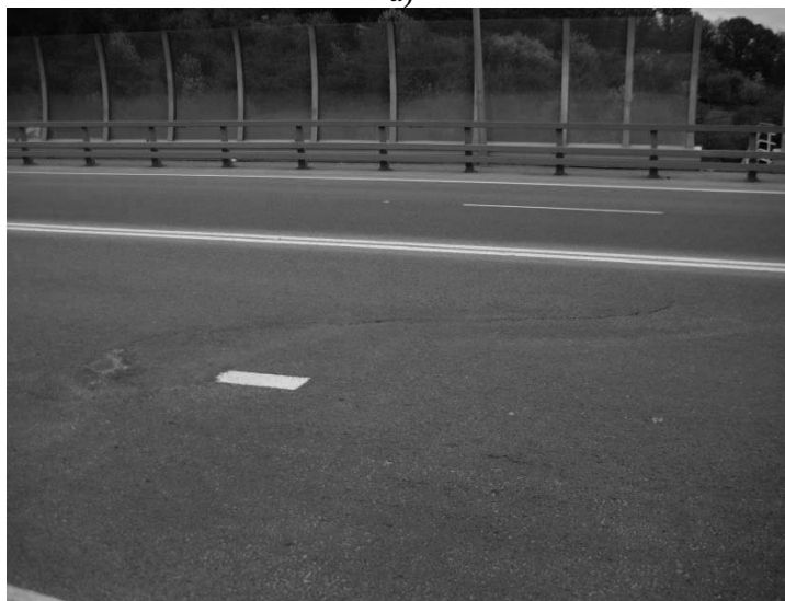
Рис. 4. Развитие повреждений на дорожной одежде эстакады
