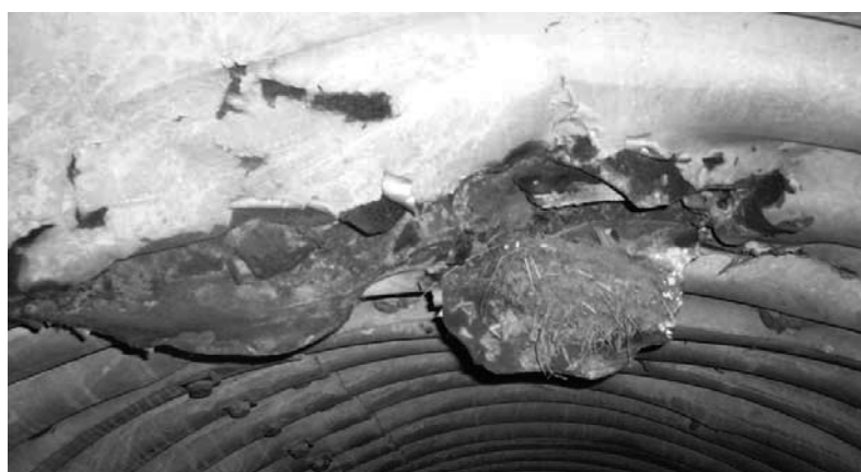
Рисунок - 5 Местный разрыв тела трубы
