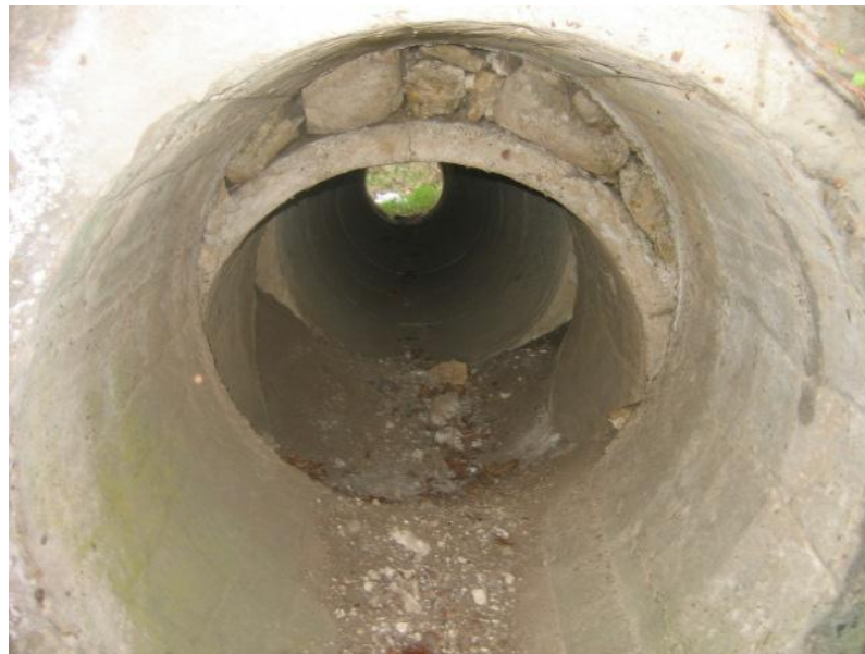
Рис. 3 Просідання кільця в тілі труби
