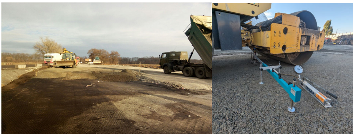
Рисунок 4 – Улаштування георешітки Tensar та виконання статичних вимірювань Figure 4 – Laying the Tensar geogrid and performing static measurements
