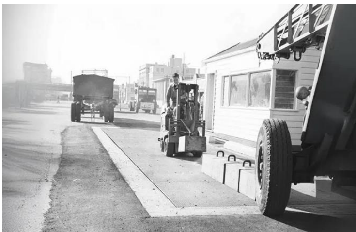
Рисунок 1 – Перший експериментальний майданчик зважування в русі, США 1958 р. [1]
