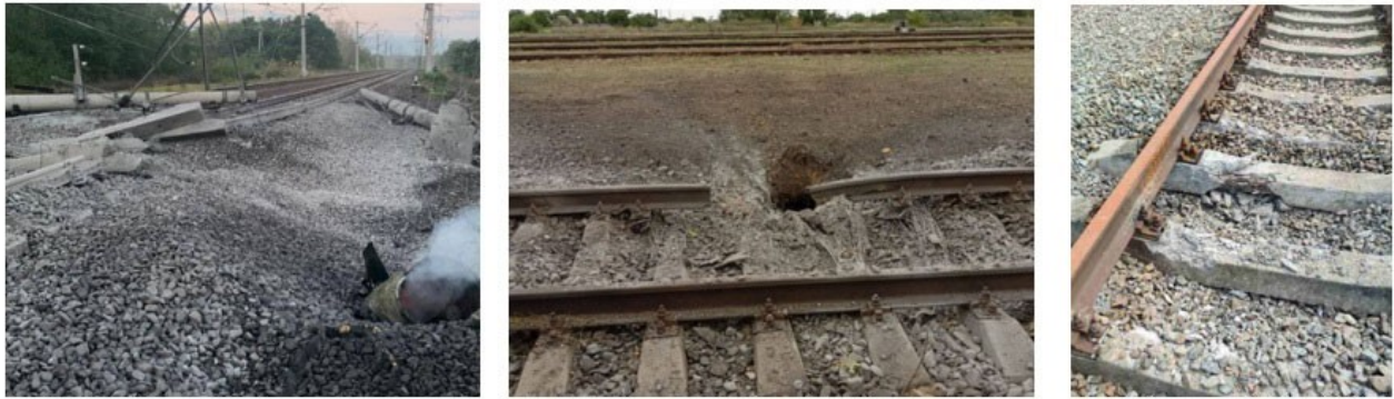
Рисунок 7 – Виявлені за допомогою БПЛА пошкодження на досліджуваній ділянці Figure 7 - Damage detected by UAVs in the study area
