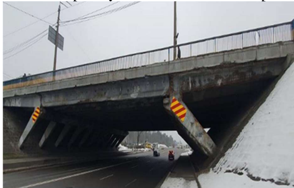
Рисунок 1 – Вид на фасад шляхопроводу
