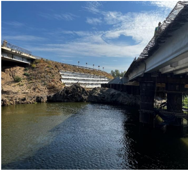
Рисунок 11 – Використання балок ВТП-15 для укріплення конусу тимчасового об'їзду.
