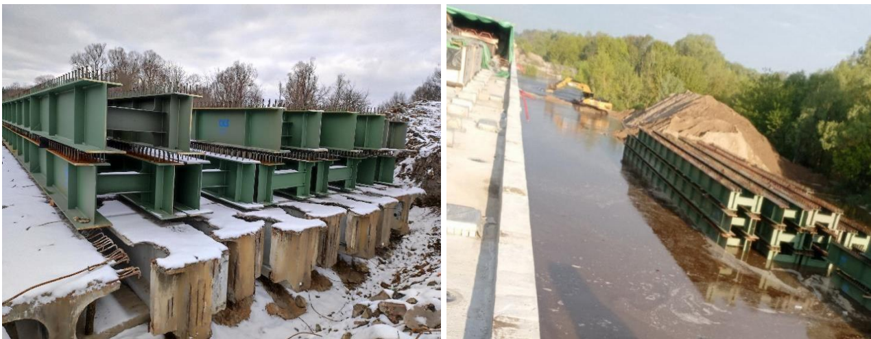
Рисунок 9 – Зберігання нової прогонової будови на демонтованих балках.
