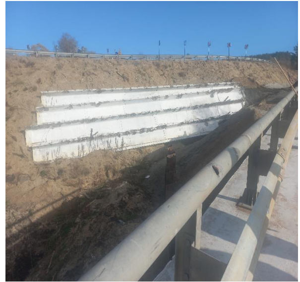
Рисунок 11 – Використання балок ВТП-15 для укріплення конусу тимчасового об'їзду.
