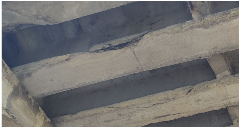
Рисунок 5 — Характерні відколи бетону утворені внаслідок розриву струн Figure 5 — Characteristic concrete spalling caused by string breakage
