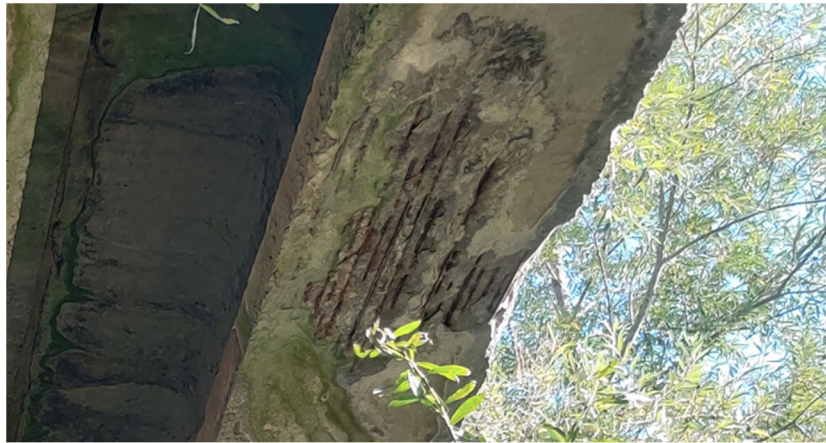
Рисунок 4 — Руйнування захисного шару бетону із оголенням та корозією струн спричинене інтенсивним замоканням бетону та недостатньою товщиною захисного шару бетону Figure 4 — Failure of the concrete protection layer with exposure and corrosion of the strings caused by intensive wetting of the concrete and insufficient thickness of the concrete protection layer
