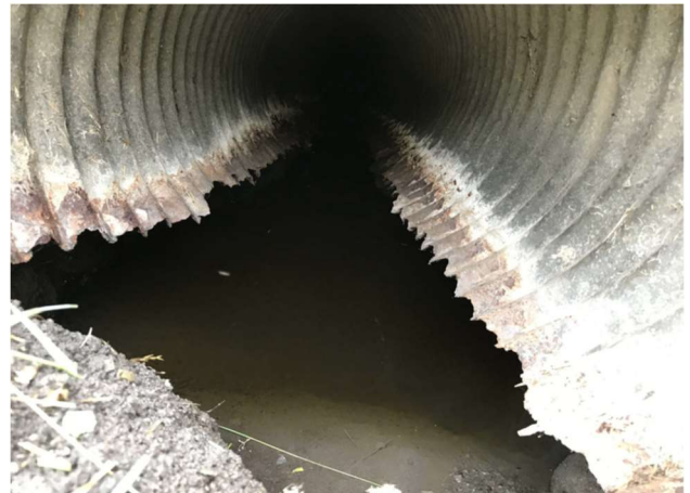
Рисунок 4 – Критичне пошкодження дорожньої водопропускної труби Figure 4 – Critical damage of the road culvert
