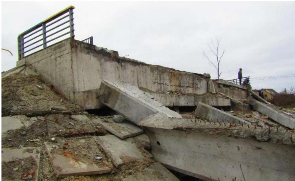
Рисунок 2 – Міст через р. Ірпін (правий) Figure 2 – The bridge over the Irpin river (right)
