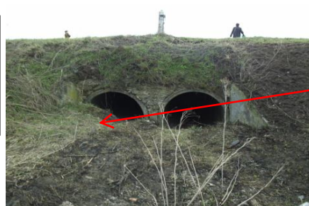
Рис. 9. Труба залізобетонна №6 ПК 11+848: вхідний (а) і вихідний (б) оголовки
