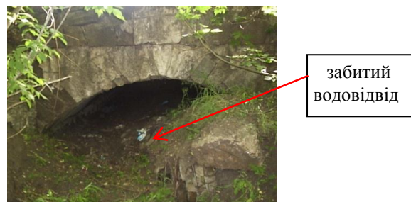
Рис. 1. Труба залізобетонна №51, ПК95+360
