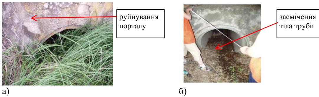
Рис. 3. Труба залізобетонна №23 ПК 49+820: вхідний (а) і вихідний (б) оголовки
