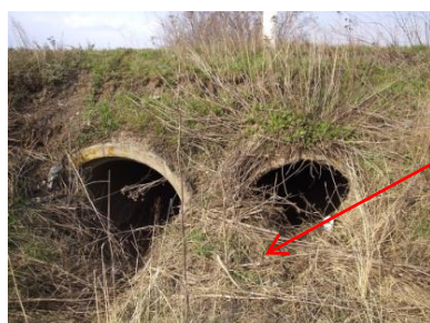
Рис. 9. Труба залізобетонна №6 ПК 11+848: вхідний (а) і вихідний (б) оголовки
