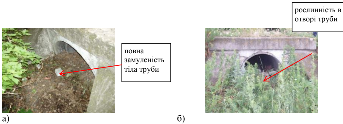
Рис. 4. Труба залізобетонна №25 ПК 53+130: вхідний (а) і вихідний (б) оголовки
