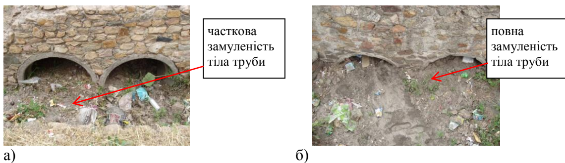
Рис. 5. Труба залізобетонна №13 ПК 33+370: вхідний (а) і вихідний (б) оголовки
