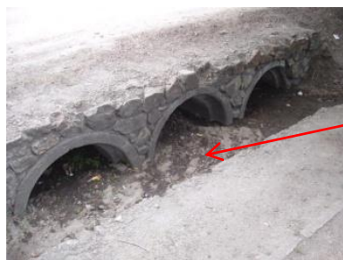
Рис. 7. Труба залізобетонна №14 ПК 33+840: вхідний (а) і вихідний (б) оголовки
