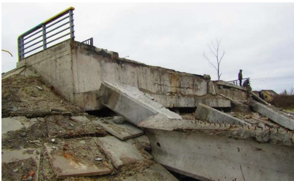
Рисунок 2 – Міст через р. Ірпінь (правий) Figure 2 – The bridge over the Irpin river (right)
