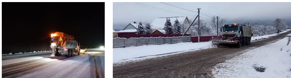
Рисунок 3 – Очищення від снігу та розподілення протижеледних матеріалів на дорозі Т-18-17 (на фото роботи виконує ПрАТ «Рівнеавтошляхбуд», січень 2024р.) Figure 3 – Clearing the road from snow and distribution of anti-icing materials on the highway T-18-17
