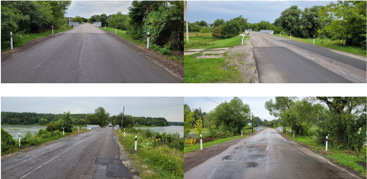
Рисунок 5 – Утримання мостових споруд на дорозі Т-18-17 (на фото роботи виконало ПрАТ «Рівнеавтошляхбуд», серпень 2023р.)
