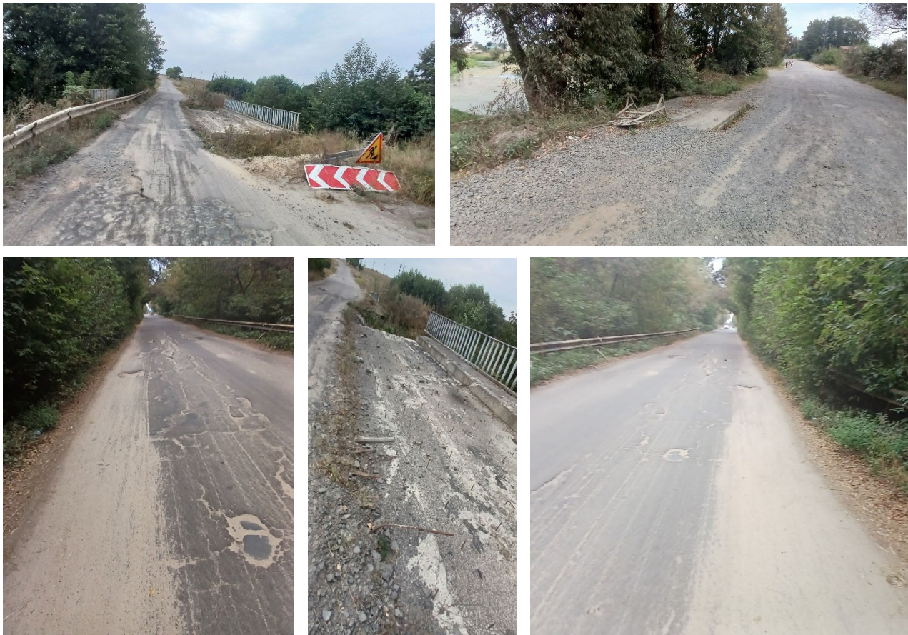
Рисунок 2 – Ділянки незавершених ремонтів мостових споруд на дорозі Т-18-17 Figure 2 – Unfinished repair sites of bridge structures on the highway T-18-17
