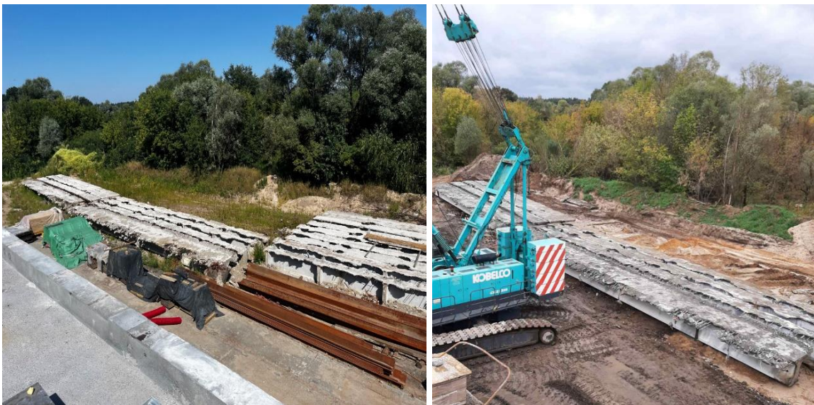
Рисунок 8 – Демонтаж та складання залізобетонних балок на будмайданчику. Figure 8 – Dismantling and assembly of reinforced concrete beams at the construction site.
