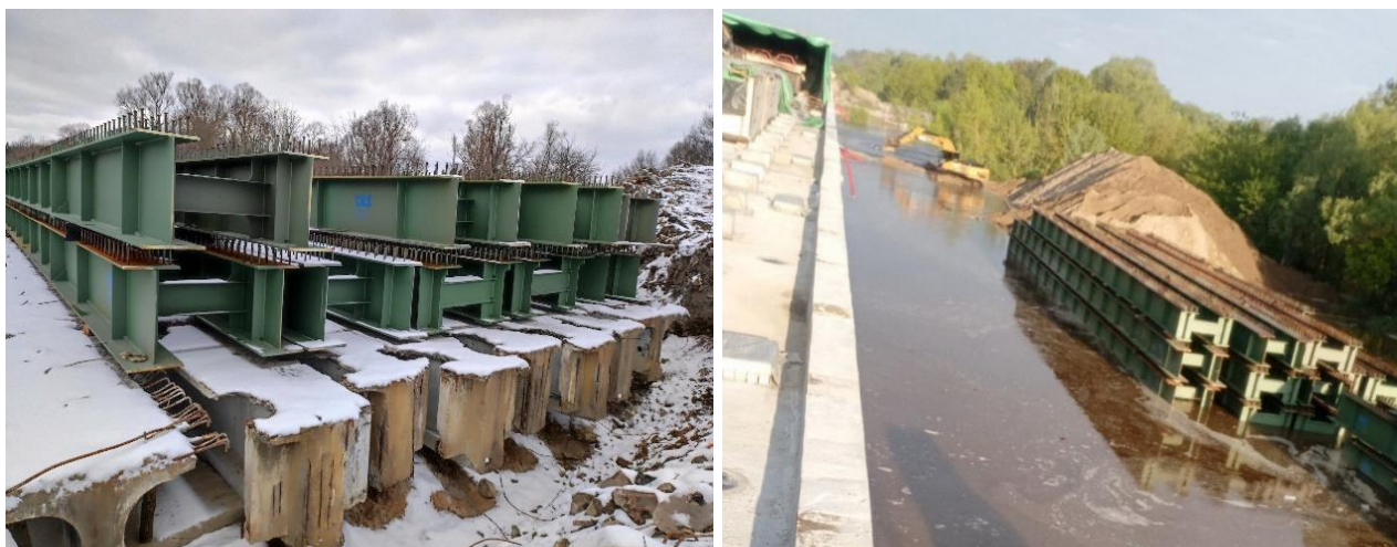
Рисунок 9 – Зберігання нової прогонової будови на демонтованих балках.
