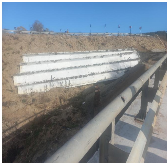
Рисунок 11 – Використання балок ВТП-15 для укріплення конусу тимчасового об'їзду. Figure 11 – Using VTP-15 beams to reinforce the temporary detour cone.
